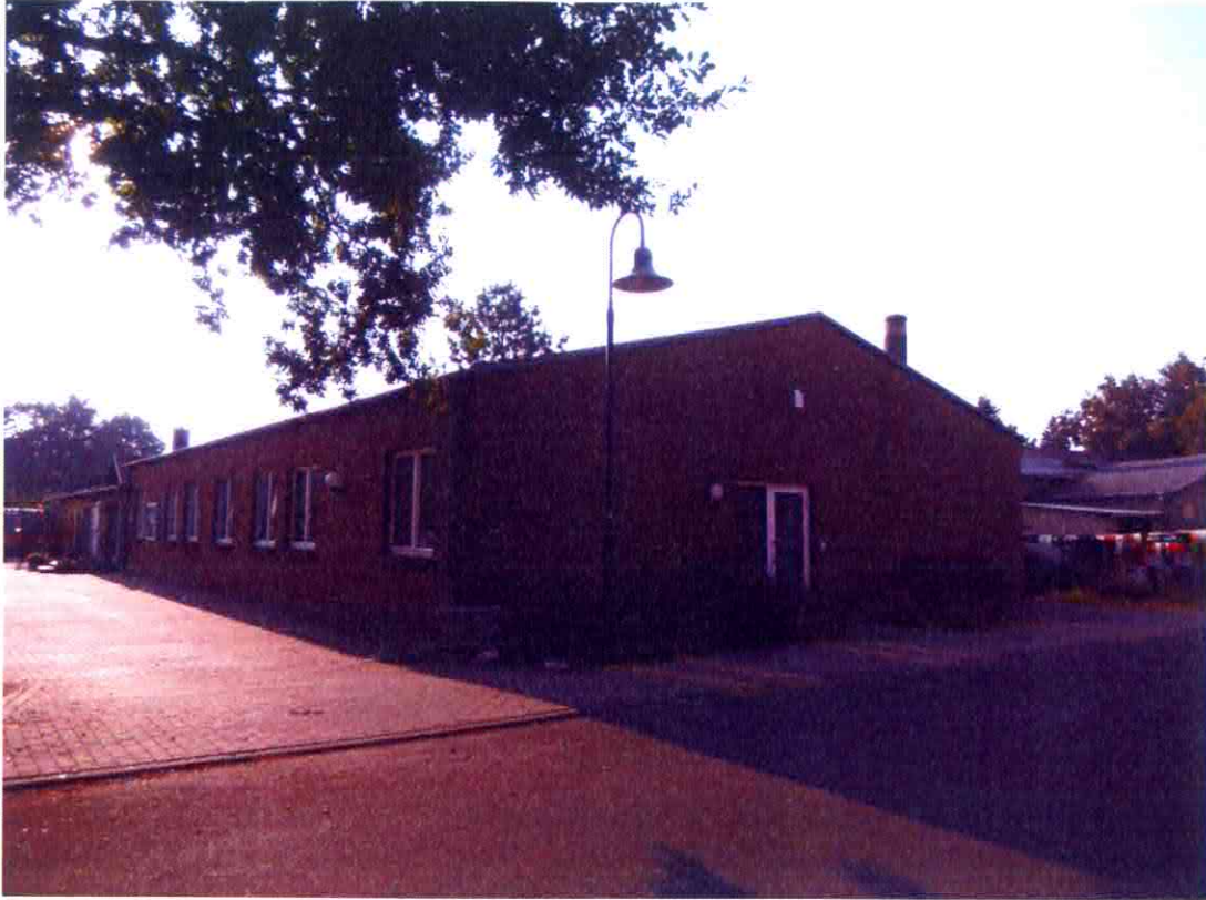
Bild 1: Giebel-/Längsansicht Haus I mit Zufahrt von der Straße „Auf dem Horst“ aus
