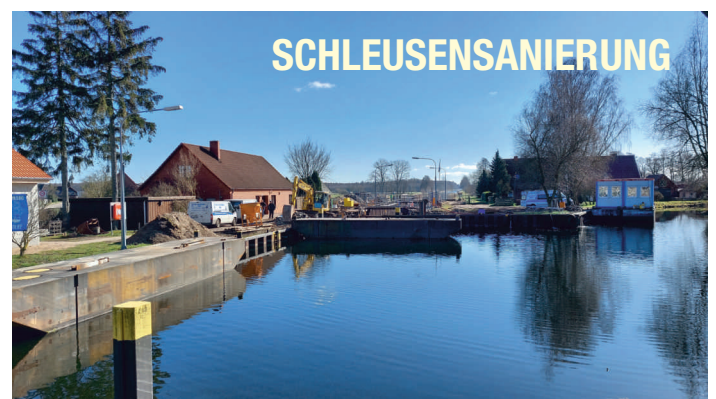
Im Februar hat die Sanierung der Schleuse in Bankkow wieder Fahrt aufgenommen. Ziel ist der 6. April. Am Gründonnerstag soll die neue Anlage für die Schifffahrt auf dem Störkanal freigegeben werden, so die Auskunft von Andreas Karls, dem Leiter der Außenstelle Grabow des Wasserstraßen- und Schifffahrtsamtes Elbe.
